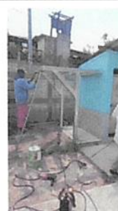
Foto 6: Instalación de estructura portante de metal sujeciones, aplicación de pintura) a puertas de servicios sanitarios
