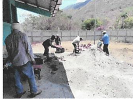
Foto 2: Reparación de planchas de concreto de patio
