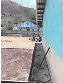
Foto 1: Reparación de planchas de concreto de patio
