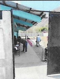
Foto 3: Mantenimiento a portones de metal
