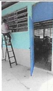
Foto 5: Mantenimiento a estructura (lijado, cambio de tubo, cepillado, sujeciones, aplicación de pintura) a puertas de servicios sanitarios
